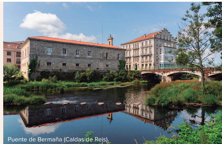
Puente de Bermaña (Caldas de Reis)
